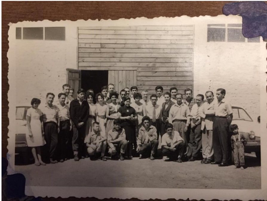
Fot. 13 Personal de la Planta.
